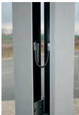
Abb. 10.32: Kabelführung Rahmen – Flügel
